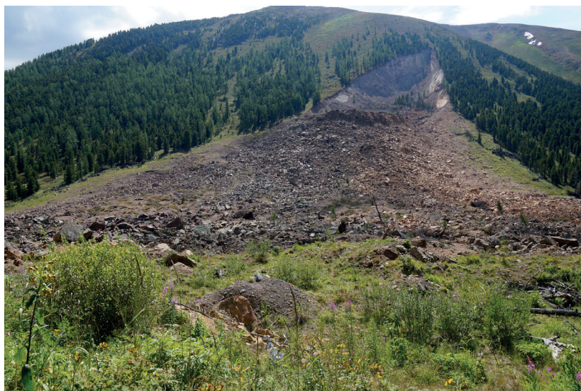
Рис. 4. Общий вид скального оползня. На переднем плане виден конус рыхлого материала Fig. 4. General view of the rock avalanche. A cone of loose material is visible in the foreground, indicating the presence of permafrost
